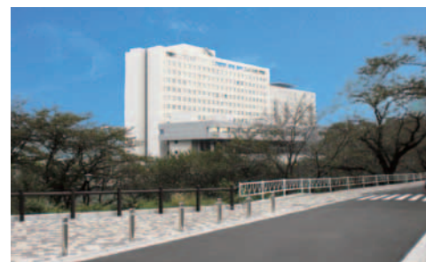
新しく舗装された3学部と病院をつなぐ連絡道路
