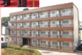
レジデントハウス外観
